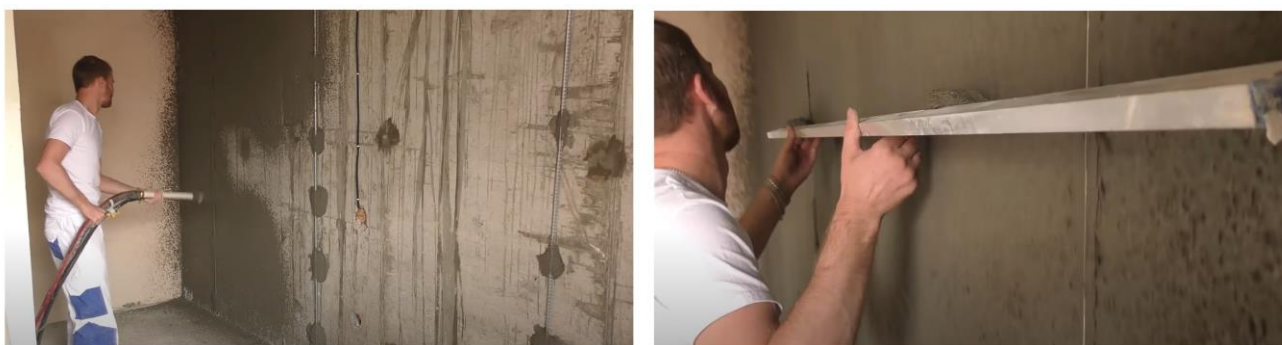
Рис. 26. Схема нанесения обрызга на поверхность и разравнивание правилами образовавшихся наплывов
